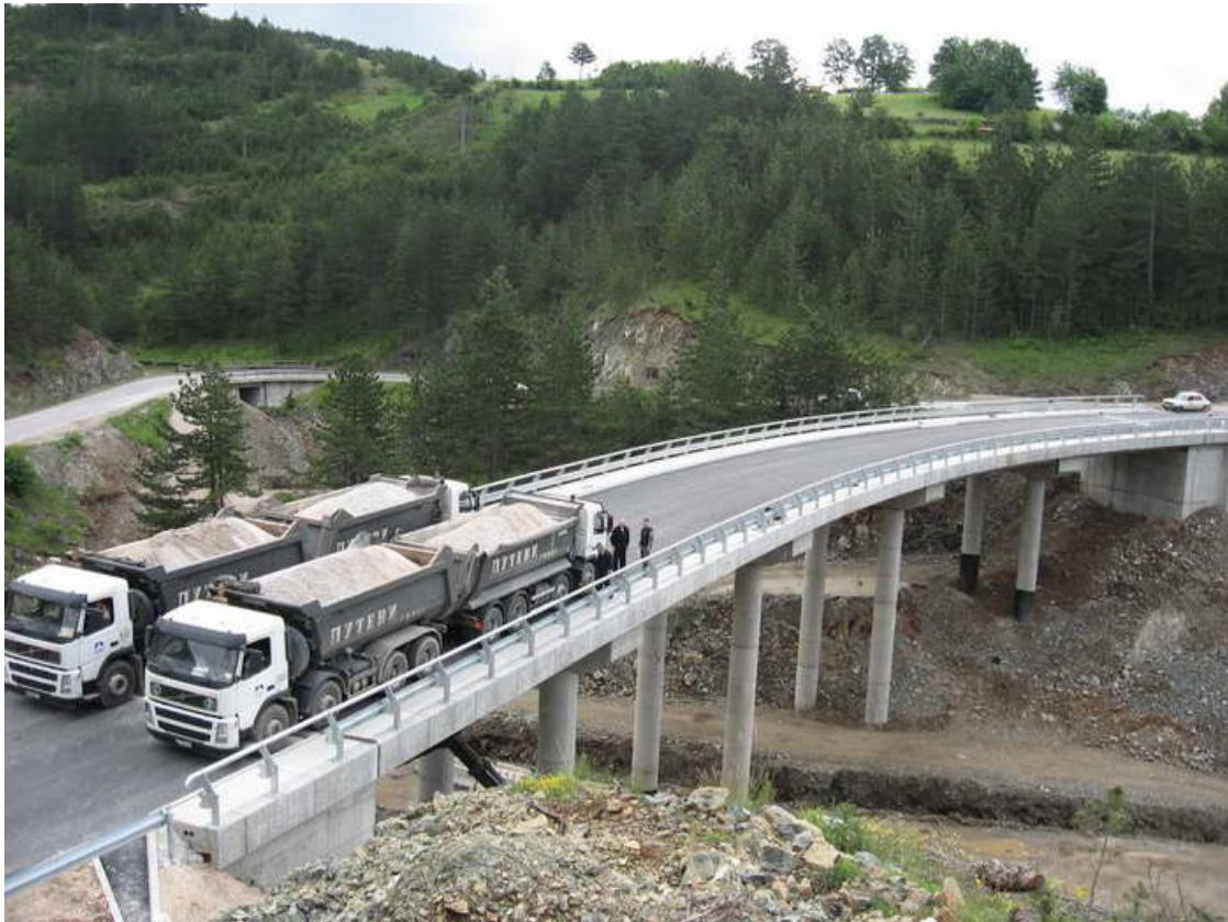
**Fotografija 1.1:** Statičko ispitivanje konstrukcije mosta
