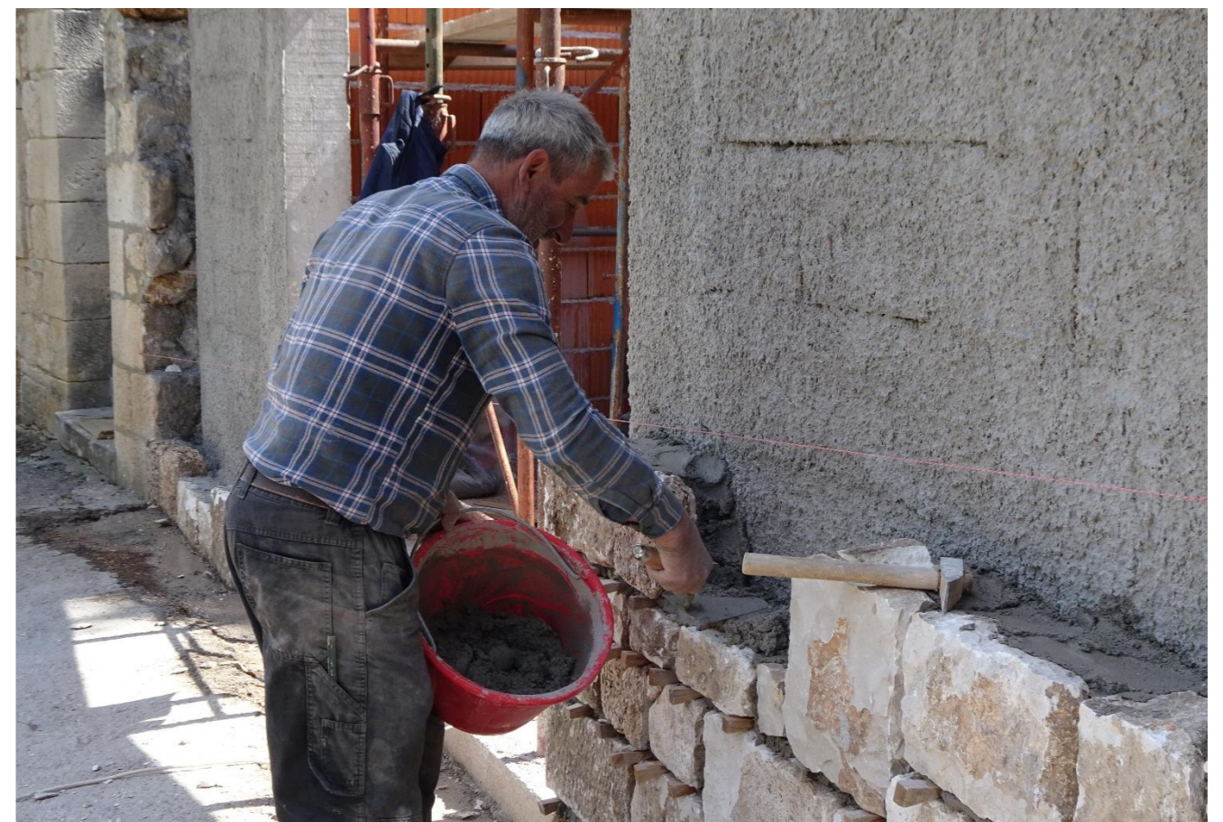
Slika 28_ Gospodin Žarko Gospodnetić, majstor građevinskih umijeća, vješto izvodi radove kao kamenoklesar, krovopokrivač i zidar
