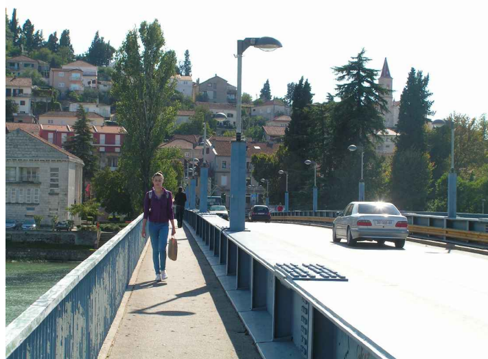
Pješački potez mosta
