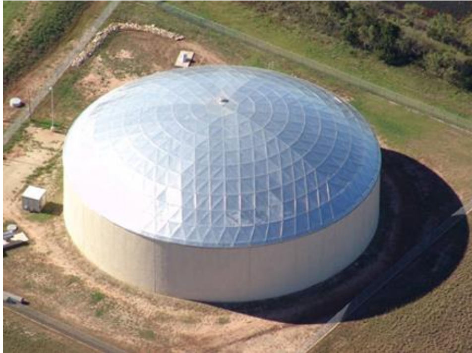
Slika 3. Nadzemni spremnik sa aluminijskom kupolom
