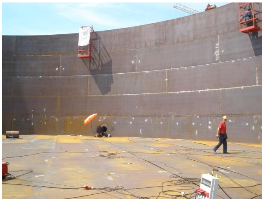
Slika 9. Plašt spremnika u izgradnji
