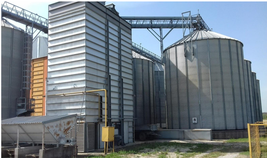
Slika 5. Silos u Drenovcima kapaciteta 850 t (Foto: Oliver Kandrać)
