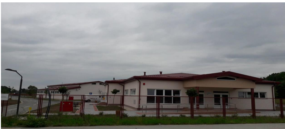
Slika 6. Upravna zgrada PPID
