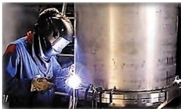
Slika 26. Reparaturno zavarivanje nehrđajuće posude za vodu u sustavu napajanja stoke
