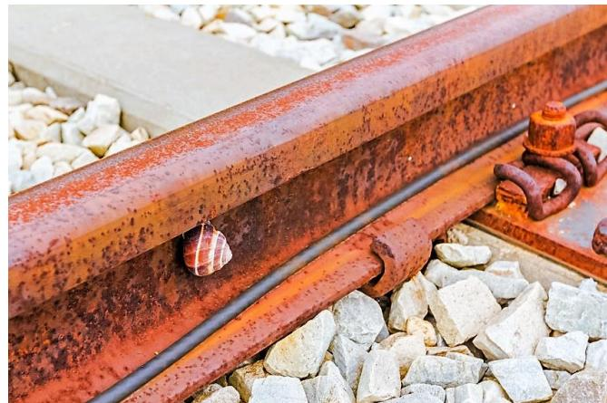
Slika 5. Elektrokemijska korozija tračnice i spojeva željezničke pruge
