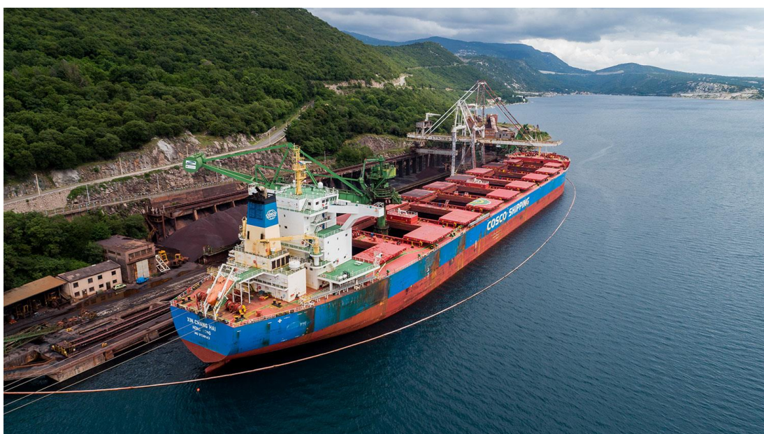
Slika 3. Terminal za rasuti teret Bakar
