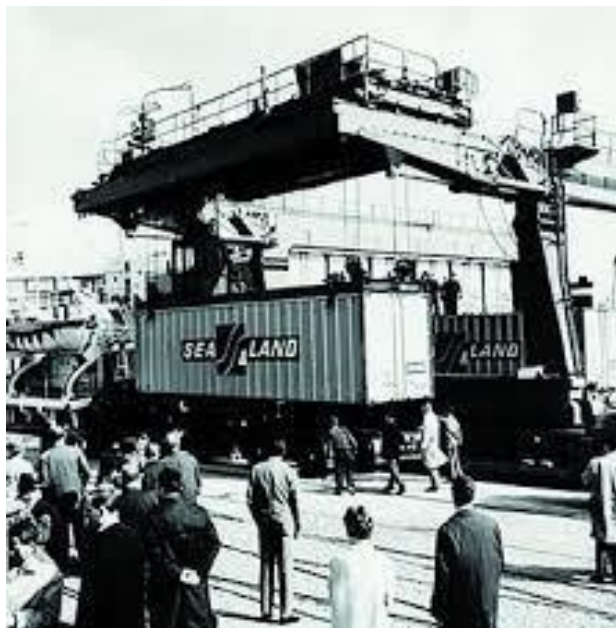
Slika 1. Prekrcavanje kontejnera u početku konterizacije
