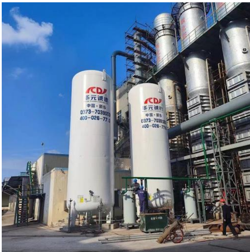
Slika 6: Spremnik za skladištenje ukapljenog prirodnog plina
