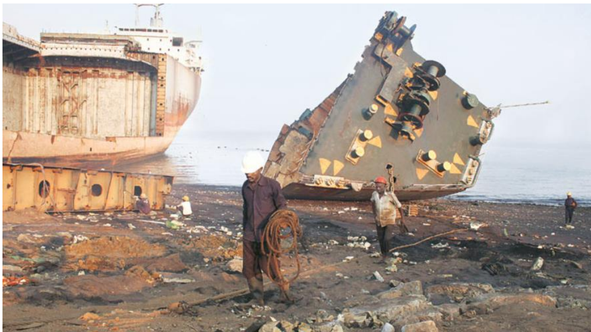
Slika 19. Rezanje sekcija na plaži u Bangladešu [18]
