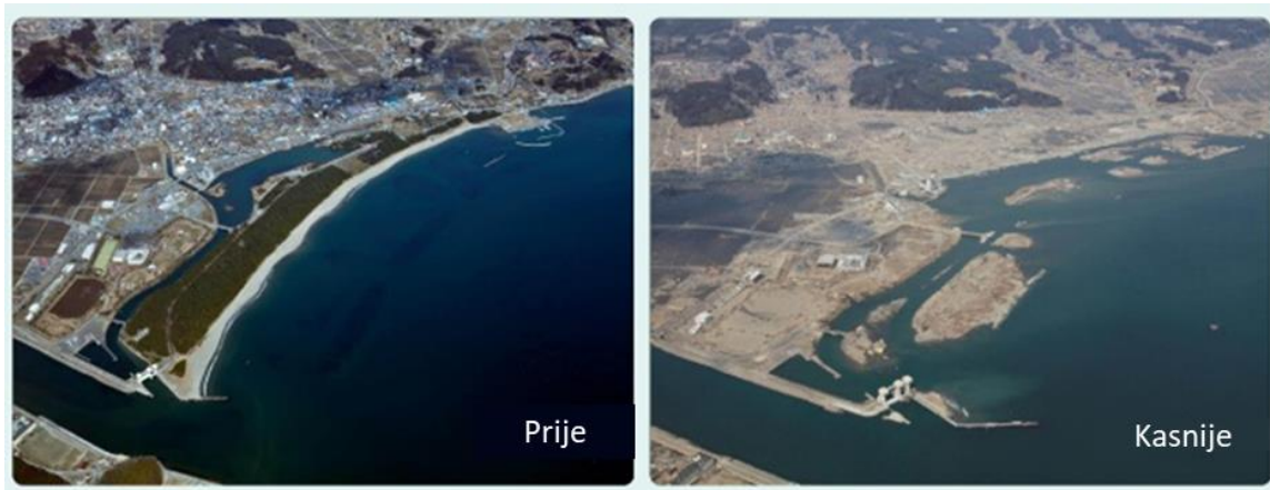
Sl.7. Luka Rikuzentakata prije i poslije tsunamija Izvor: Nohara (2011)
