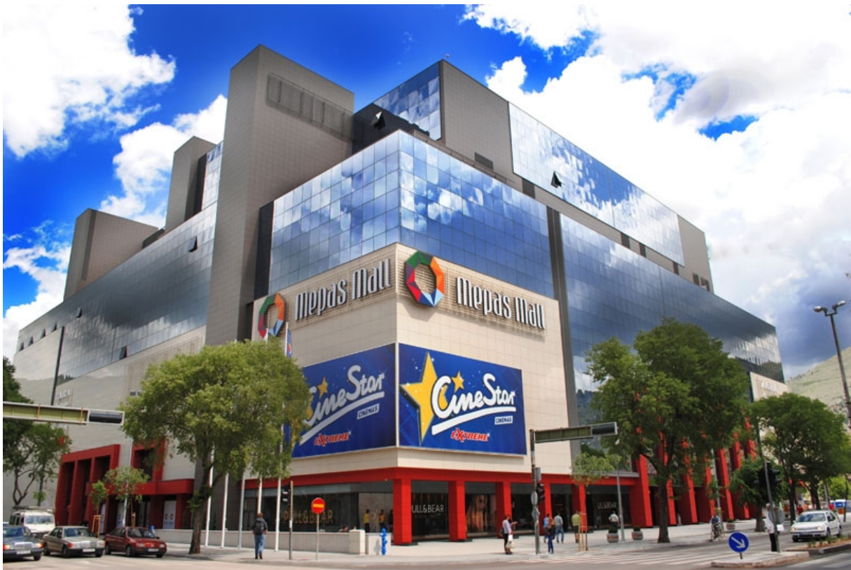
Sl. 28. Mepas mall kao primjer najvećeg suvremenog poslovnog centra grada Mostara
