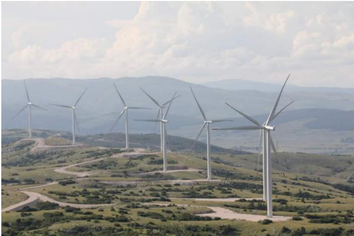
Sl. 44 Vjetroelektrana Mesihovina na Grabovičkoj zaravni
