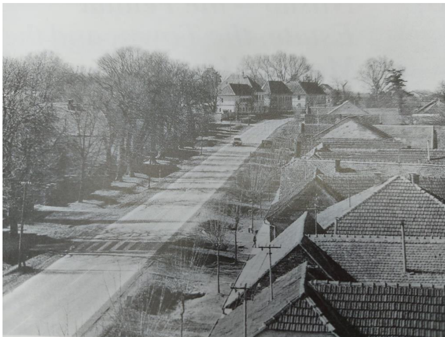
Sl. 8: Pogled na dvorac i selo
