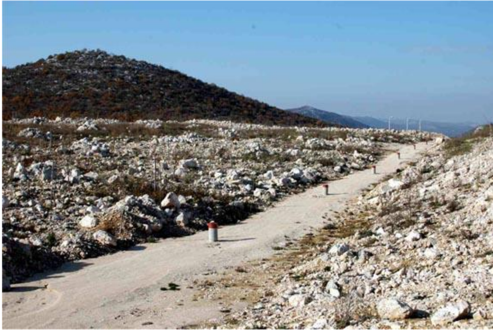
Slika 15. IC senzori i kontrolna traka na zelenom mostu Osmakovac (izvor: http://www.drypis.info/2006/ZelenimostOsmakovac/tabid/196/Default.aspx )
