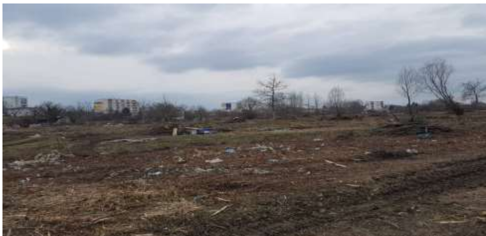
Sl. 17. Lokacija gradnje budućeg nogometnog kampa Pampas u Osijeku, 16. 12. 2017. god.
