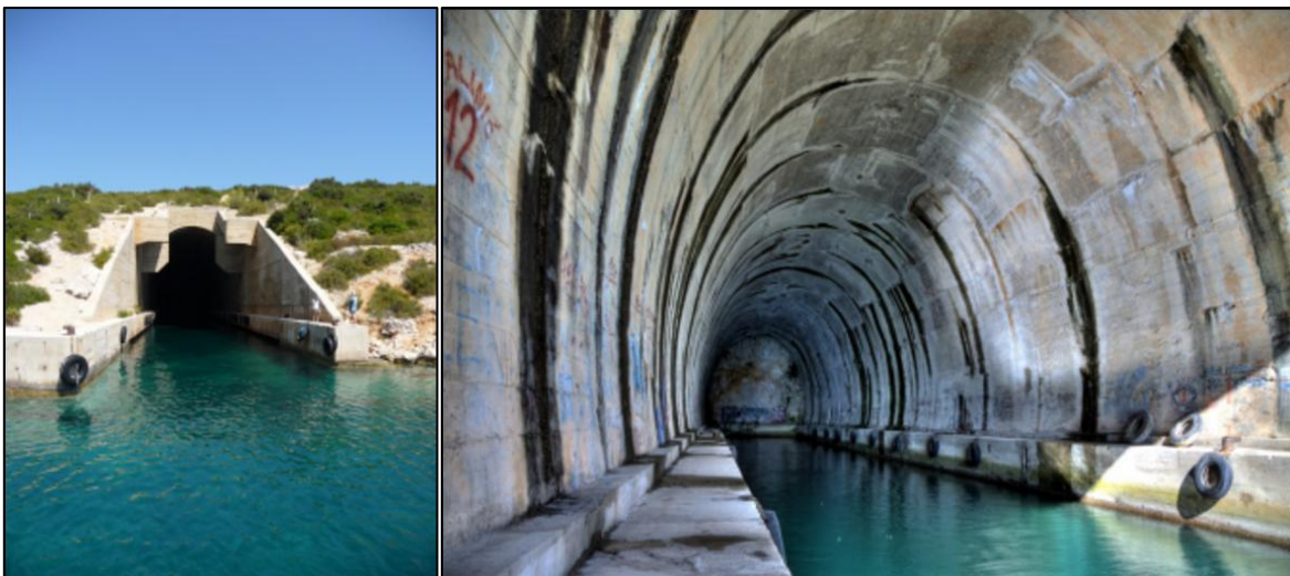
Sl. 8. Ulaz u potkop za brodove
