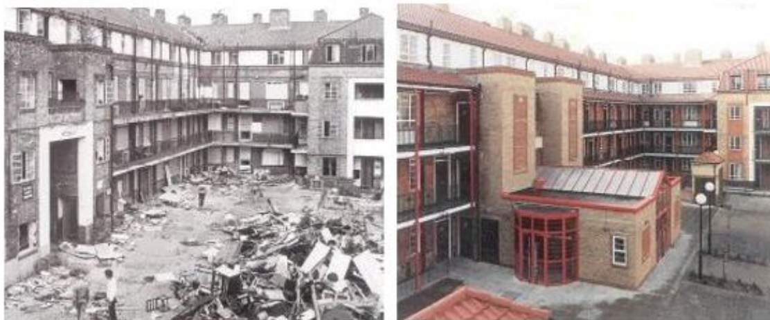
Sl. 10 Devastirana zgrada i njen obnovljen izgled, London Docklands
