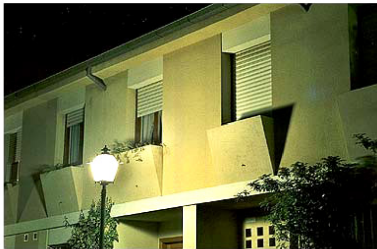
Slika 2. Ova loše postavljena ulična rasvjeta direktno osvjetljava spavaće sobe ljudi koji žive u zgradi pokraj. Nedostatak mraka može kod tih ljudi dovesti do nesanice, poremećaja cirkadijskih ritmova te u konačnici i do ozbiljnijih zdravstvenih problema
