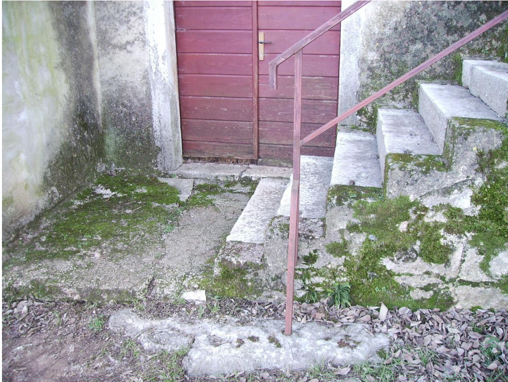
Slika 8. Staro betonsko podnožje i dijelovi stepeništa na kojima rastu mahovine, prosinac 2014. (fotografirao Dino Babić).
