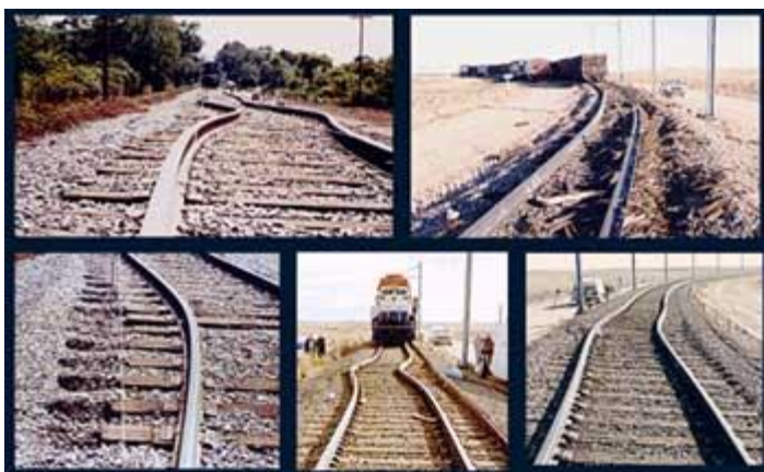
Slika 18. Izobličenje na tračnicama zbog zagrijavanja 55
