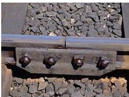
Slika 17. Primjer procijepa na tračnicama 56
