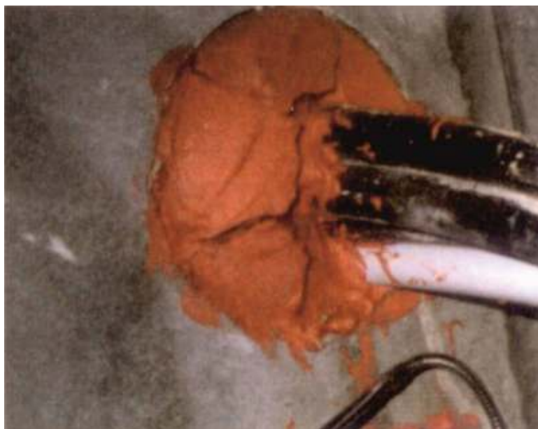
Slika 20. Brtvljenje proboja
