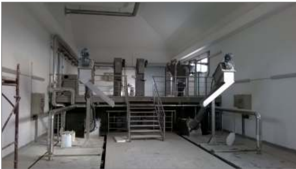
Slika 7: Automatska rešetka i kombinirana jedinica
