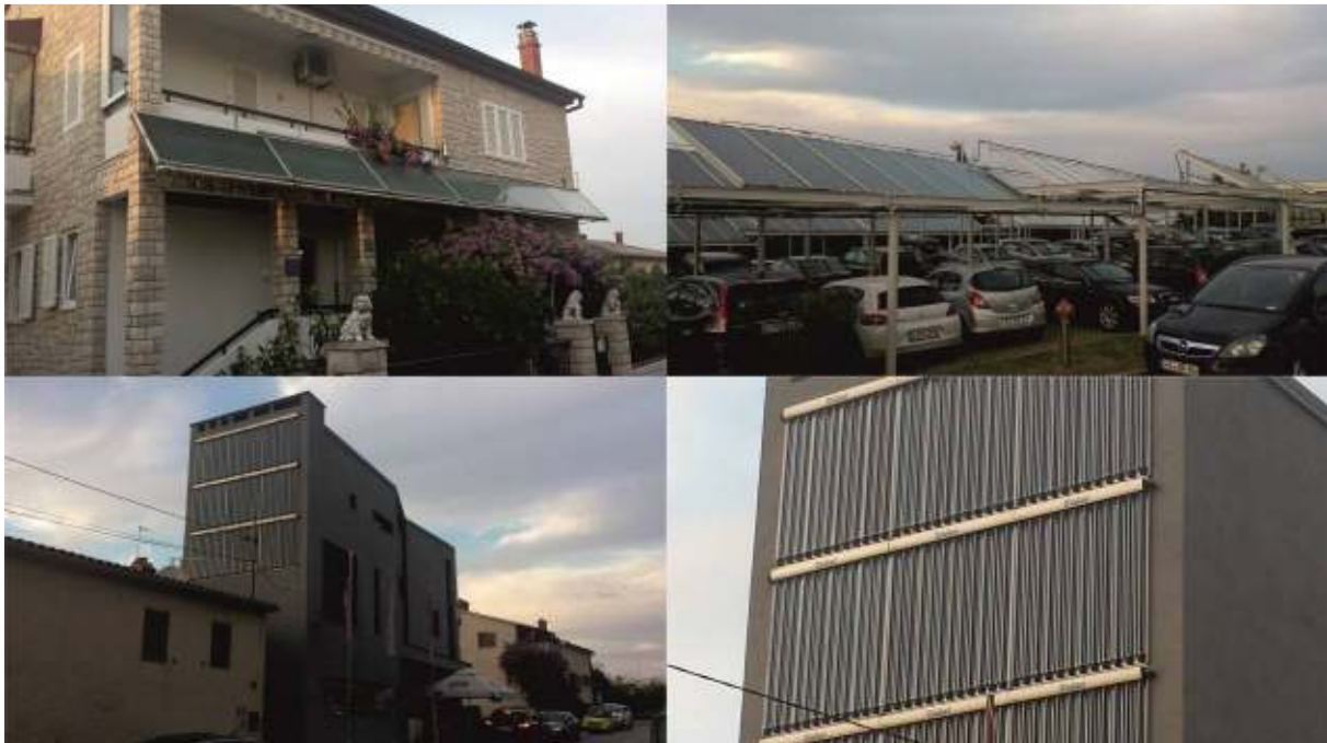
Slika 31. Razni primjeri montaže solarnih panela
