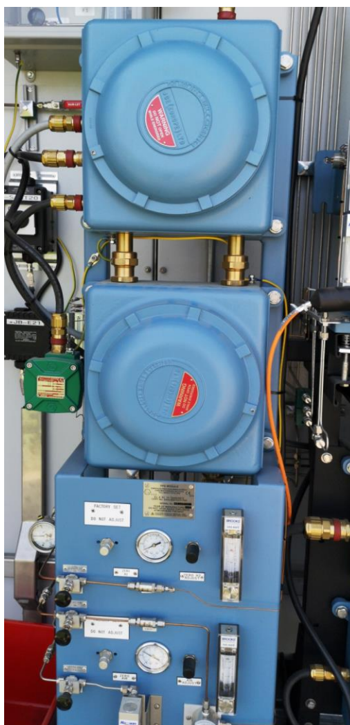
Slika 5-12. 700XA kromatograf za mjerenje udjela sumpornih spojeva
