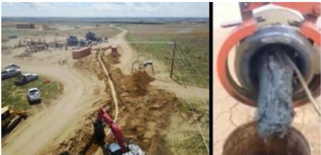
**Slika 3-11.** Postavljanje ojačanih PA-PERT cijevi promjera 152,4 mm (6") (lijevo) i čepovi parafina u čeličnoj cijevi (desno) (Chang i ostali, 2018)
