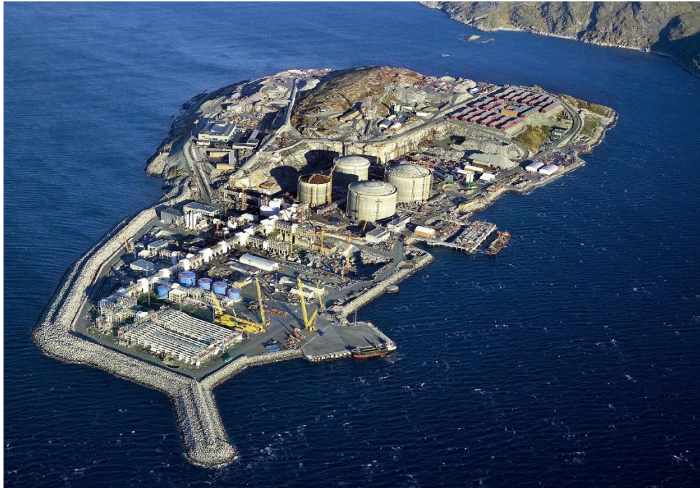
Slika 2-4. Terminal za ukapljivanje plina Snohvit (www.norskipetroleum.no, 2020)
