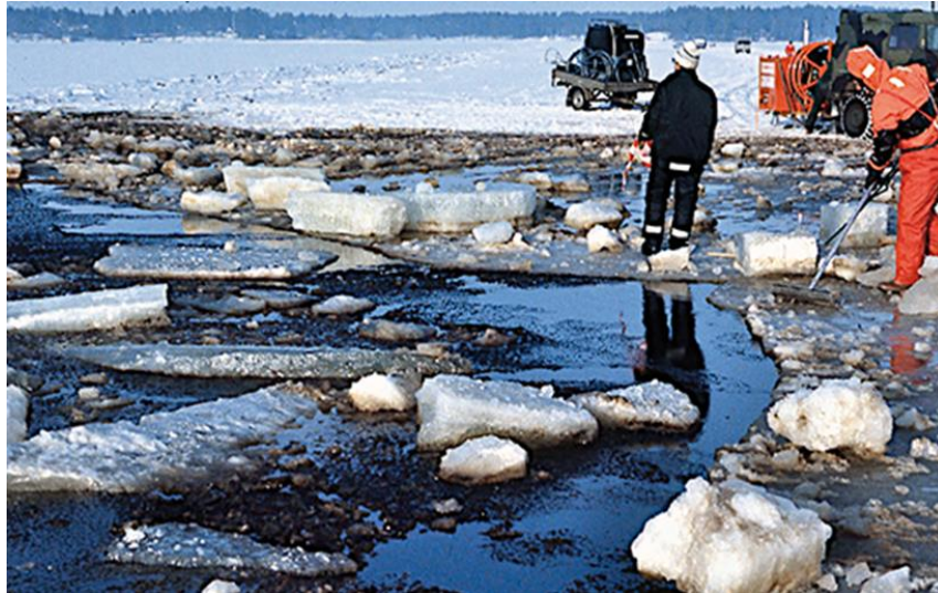
Slika 3-7. Sanacija ugljikovodika na zaleđenom području (SSPA 2010)
