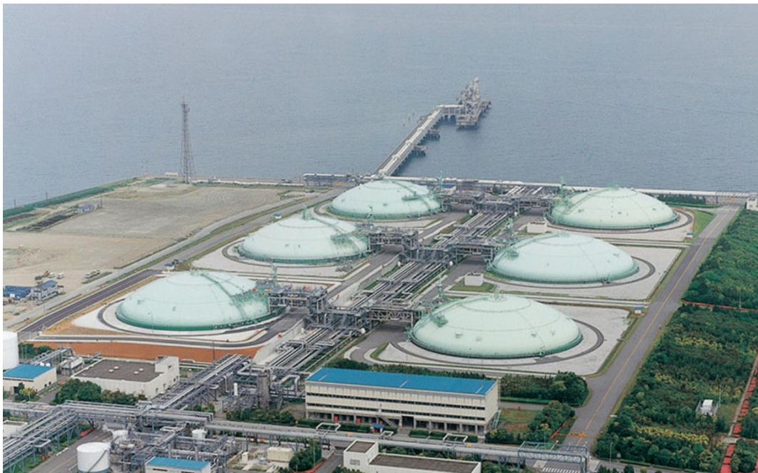
Slika 3-2. Podzemno skladište ukapljenog prirodnog plina u Japanu
