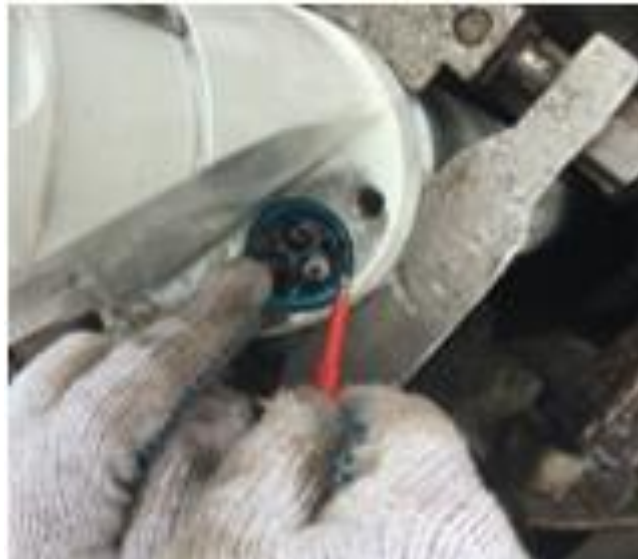
Slika 4-8. Zamjena transportnih s radnim brtvama (INA d.d., 2019)
