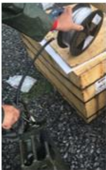
Slika 4-14. Punjenje i montaža kapilarnog voda (INA d.d., 2019)
