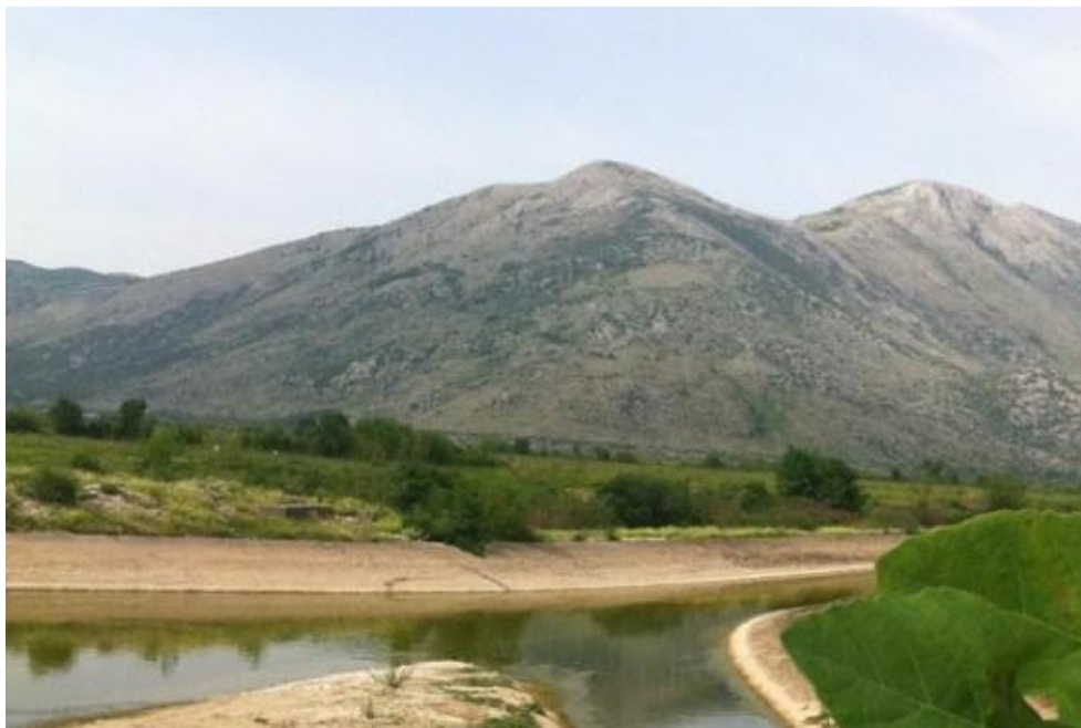
Slika 2-3. Betonirano korito Trebišnjice
