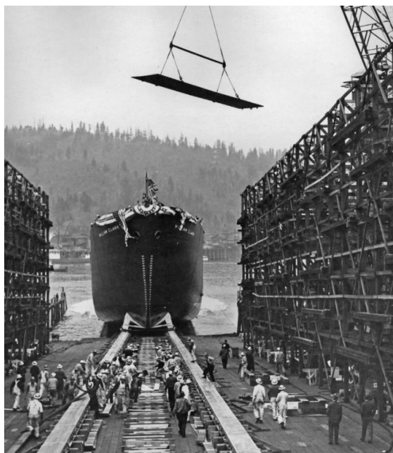
Slika 6.1. Uzdužno porinuće na kosom navozu
