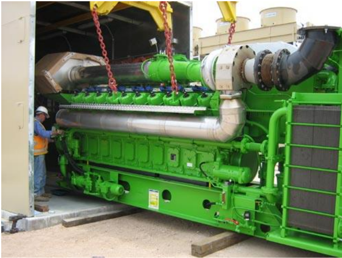
Slika 4.2 Plinski motor [18]
