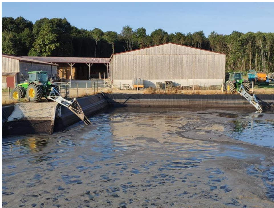
Slika 6.15 Otvoreni spremnici digestata, lagune [36]
