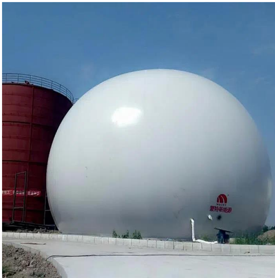
Slika 6.14 Vanjski membranski spremnik bioplina [35]
