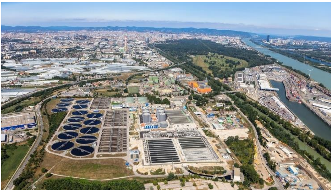
Slika 3.6 Postrojenje za pročišćavanje otpadnih voda u Beču [14]
