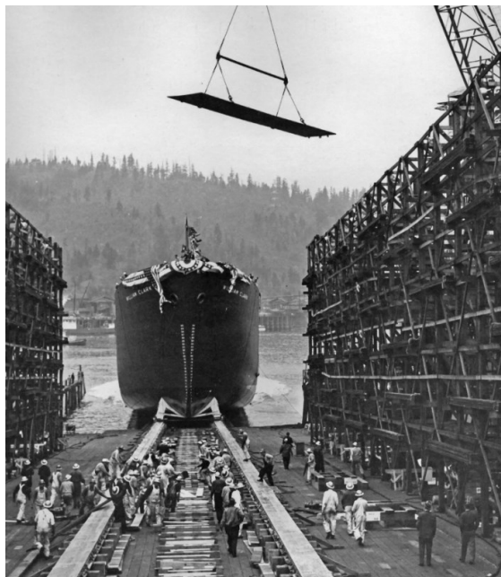
Slika 6.1. Uzdužno porinuće na kosom navozu
