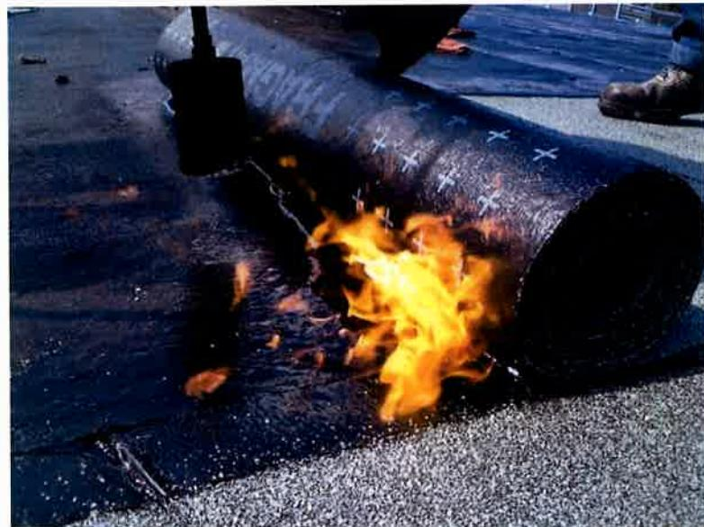
Slika 18. Ugradnja bitumenskih traka [30]
