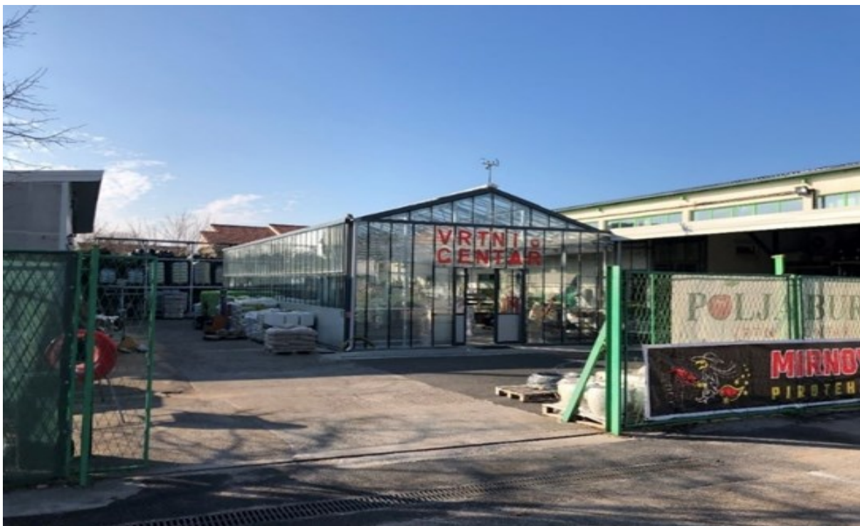
Slika 10. Postojećeg stanje poslovnog objekta
