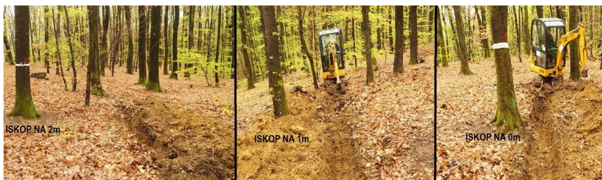
Slika 10. Iskopi na 2, 1 i 0 metara od debla
