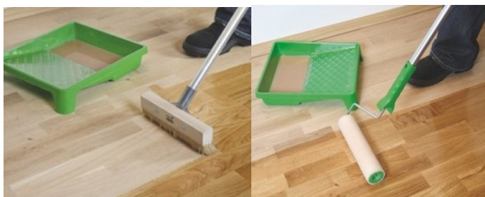
Slika 6. Nanošenje ulja četkom (ljevo) i nanošenje ulja valjkom (desno)
