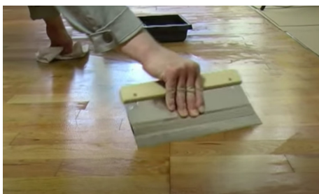
Slika 7. Nanošenje ulja lopaticom
