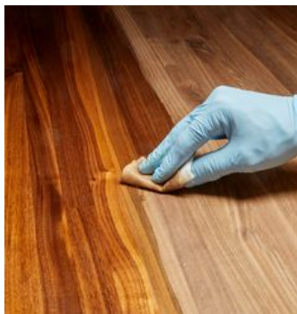
Slika 8. Nanošenje ulja krpom
