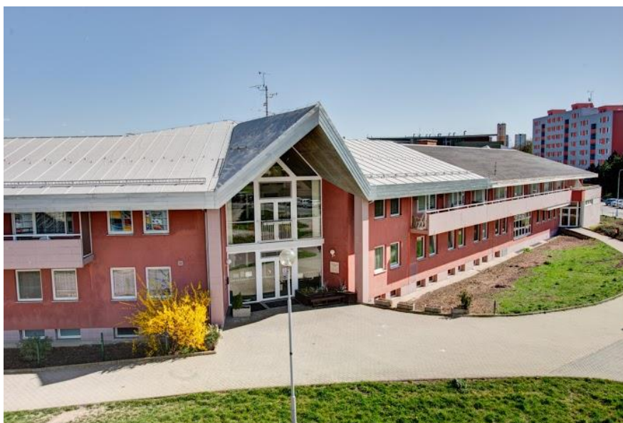
Slika 7. Zgrada doma za starije i nemoćne Podpěrova (izvor: http://www.pod.brnodcs.cz/o-nas )
