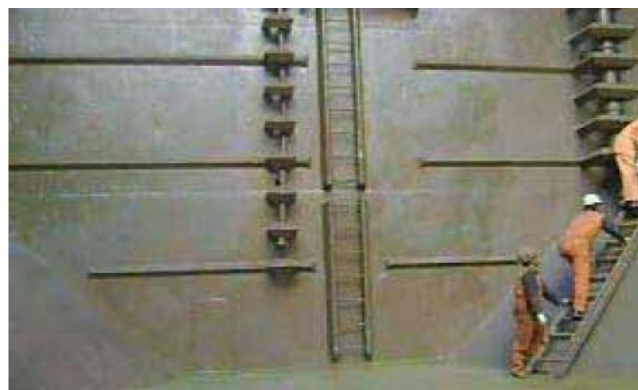
Slika 51. Čišćenje skladišta zahtjeva posadu
