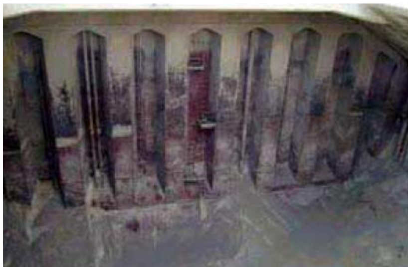
Slika 44. Ukrcaj cementa prouzrokuje prašinu u skladištu
