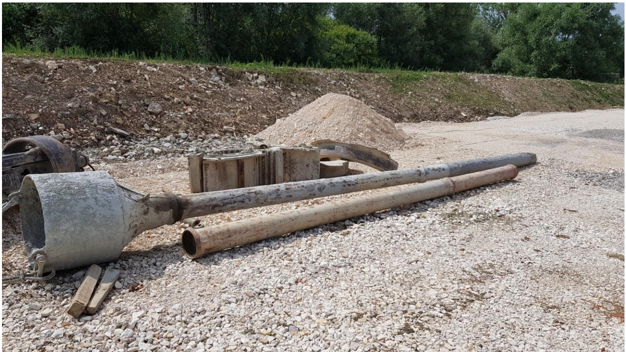
Slika 4.1.2-2 Kontraktorska cijev
