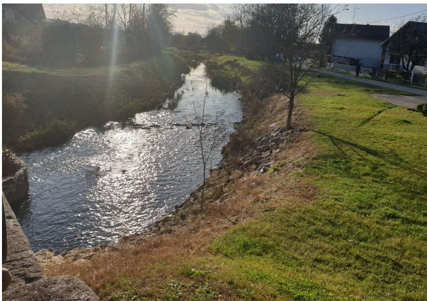
Slika 4.16 Pogled sa mosta u Jalkovcu uzvodno rijeke Plitvice [2]
