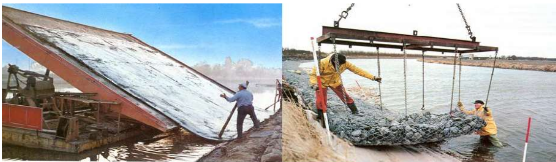
Slika 3.19 Kosa obaloutvrda s oblogom od gabionskih madraca [7]
