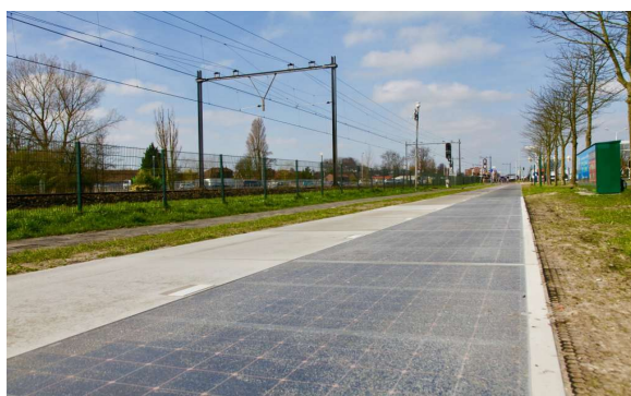
Slika 3.34 Staza od solarnih panela [22]
