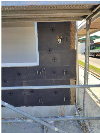
Slika 24. Tiplana izolacija kamene vune [18]
