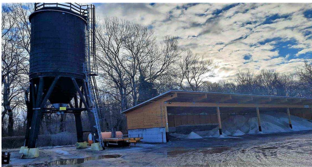
Slika: Skladišta posipala, silosne i rasute soli ( NaCl ) za posipavanje cesta u mjestu pripravnosti Varaždin – stacionar Motičnjak
