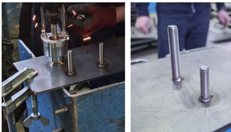
Slika 3.7. Prikaz postupka elektro-lučnog zavarivanja svornjaka sa zaštitnim plinom (lijevo) te izgled zavarenih svornjaka (desno)
