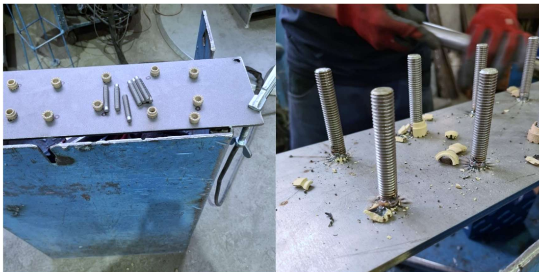
Slika 3.3. Prikaz priprema prije početka zavarivanja (lijevo) te postupak skidanja keramičkih prstenova nakon zavarivanja (desno)
