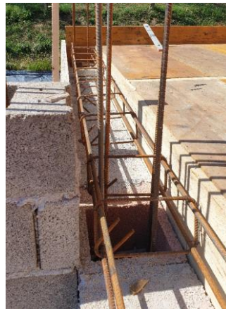
Slika. 3.3.2 Armatura za vertikalne i horizontalne serklaže
