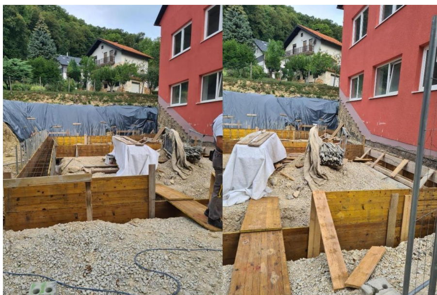
Slika 3.6.2 i 3.6.3 Oplata za temelje
