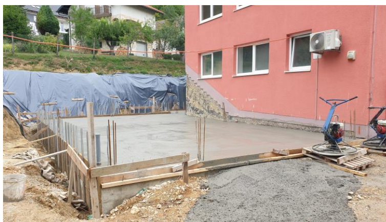
Slika 3.5.1. Prikazuje betoniranje AB podne ploče
