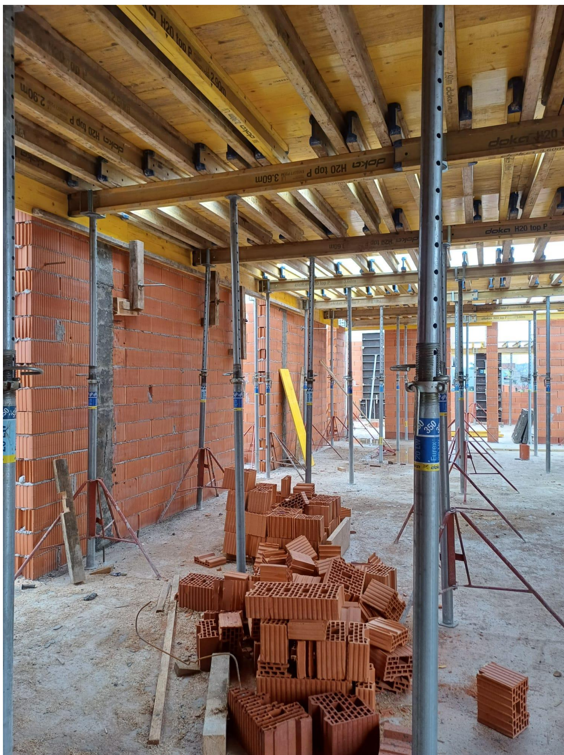
Slika 35. - Podupiranje oplata stropne ploče
