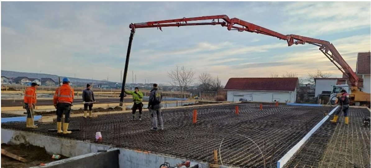
Slika 20. - Betoniranje podne ploče
