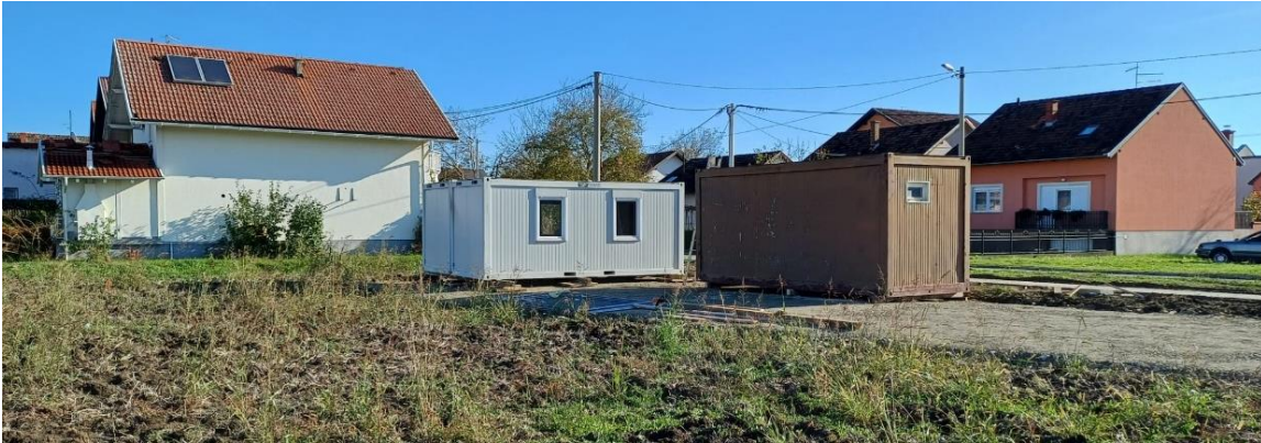
Slika 8. - Postavljanje građevinskih kontejnera
