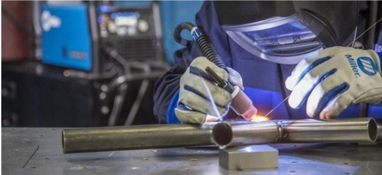
Slika 7. TIG zavarivanje cijevi od nehrđajućeg čelika [23]
