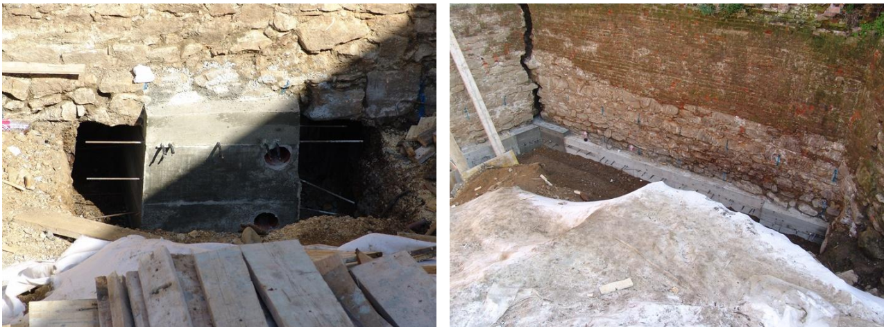
Slika 3.14. Sanacija peterokutnog bastiona
