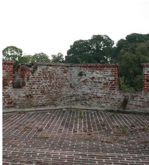
Slika 4.4. Oštećenje grudobrana SZ bastiona
