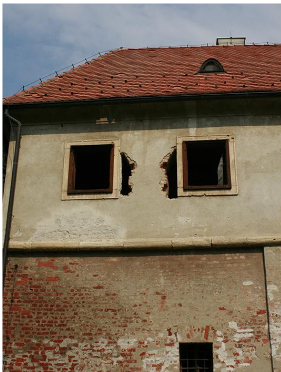
Slika 4.5. Pukotine u zidovima I. i II. dilatacije
