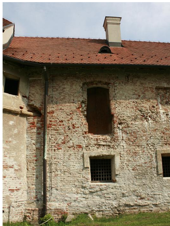
Slika 4.5. Pukotine u zidovima I. i II. dilatacije
