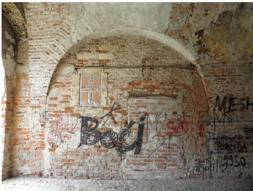
Slika 4.15. Prikaz zazidanog otvora u prizemlju
